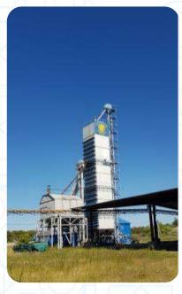
Суточная производительность зерносушильного комплекса 500 тонн/сутки.
